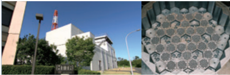
HTTR(高温工学試験研究炉)
